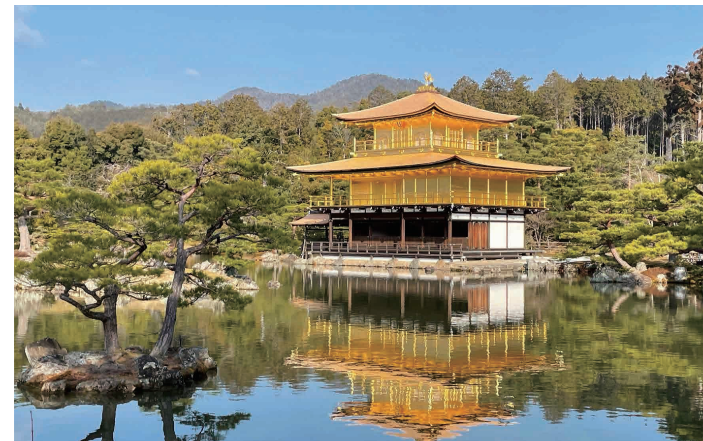
撮影地:金閣寺(2020年12月、18年ぶりに屋根のふき替え工事が完了した舍利殿)
